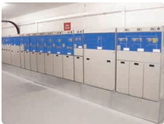
采用FOX集成的环网柜在工业系统应用示例
