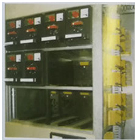
8E/4、8E/2 装置小室， 电缆和控制线连接（侧出线）
